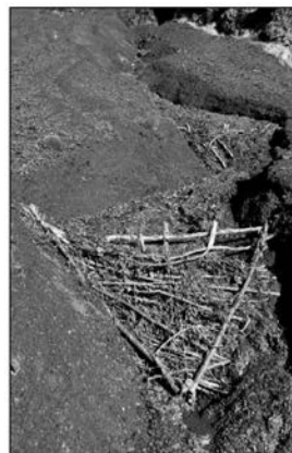
Foto 5. Microdics de ramatge per a la contenció de laves torrencials
